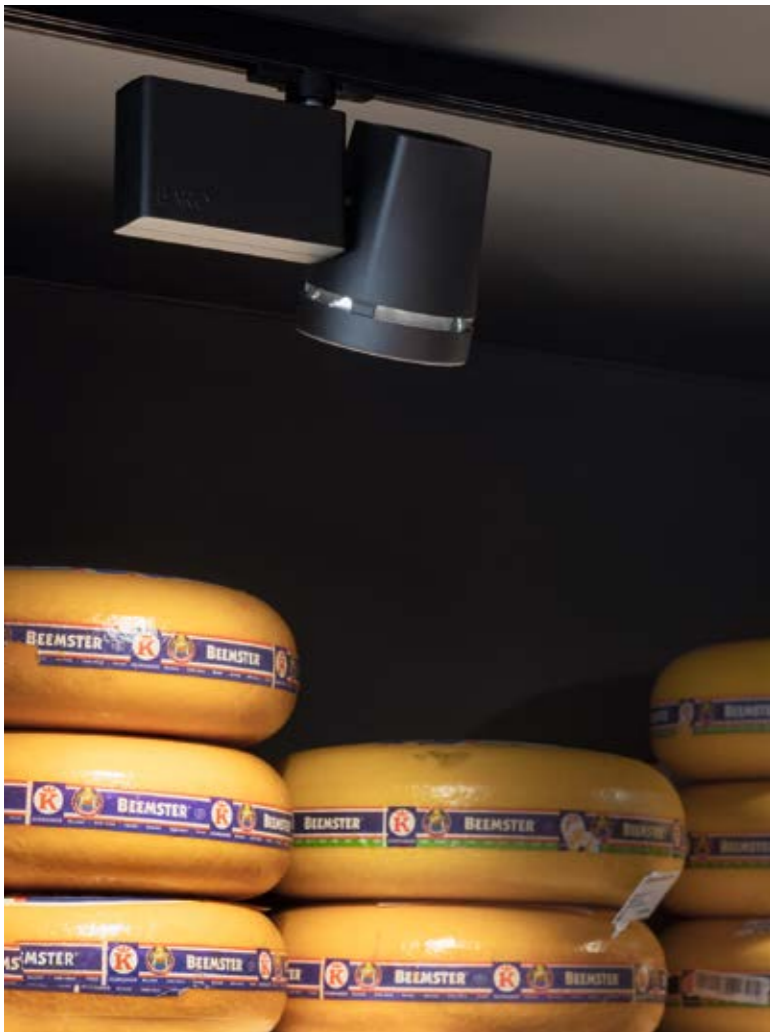
Aufgeräumtes Deckenbild: Einbauleuchten Intara RD und Strom- schienenstrahler Ontero EC.
